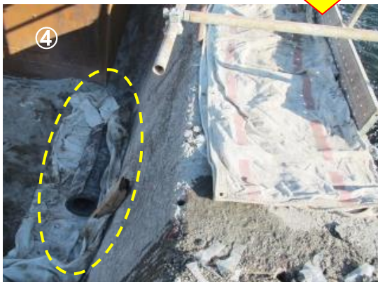
④パックの充填が終了した後、噴出現象により薬剤が 飛び散る場合があるので、防護シート等で養生する。
