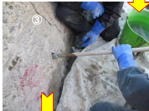
③水切りを終えたパックを1本 づつ詰め棒で押し込み4～5 回突く
