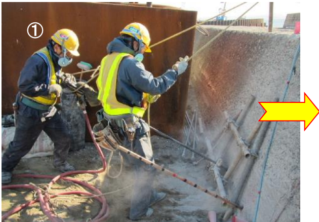
①削孔計画に沿って削孔を行う
