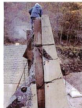
コンクリート破碎
