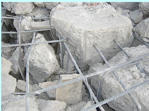
鉄筋下部も細かく破碎されている。
