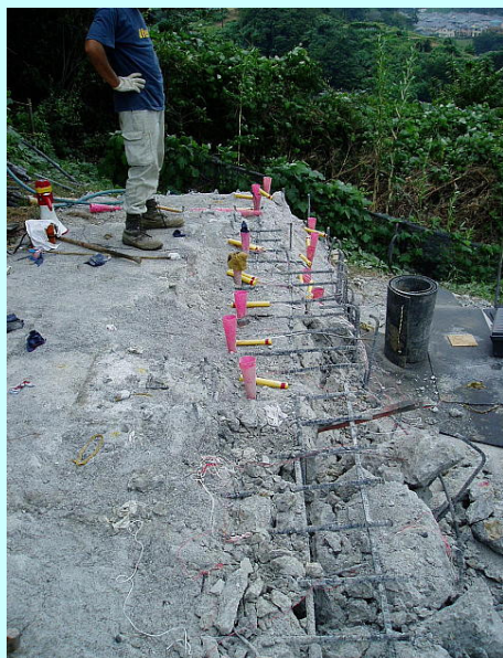
破碎箇所に装てんするガンサイザーを配る。 1列目と2列目を同時に破碎を行った。
