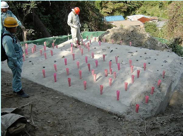
鉄筋コンクリートの基礎は、上下2段となっており、段毎に破碎を行う。上下段の削孔が終了した状態。
