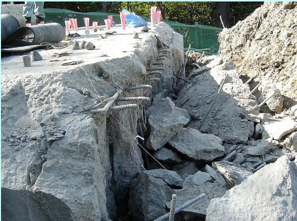
前面上部鉄筋をハツリ出し、切断しておくことで、少ない薬量で破碎することが可能となる。
