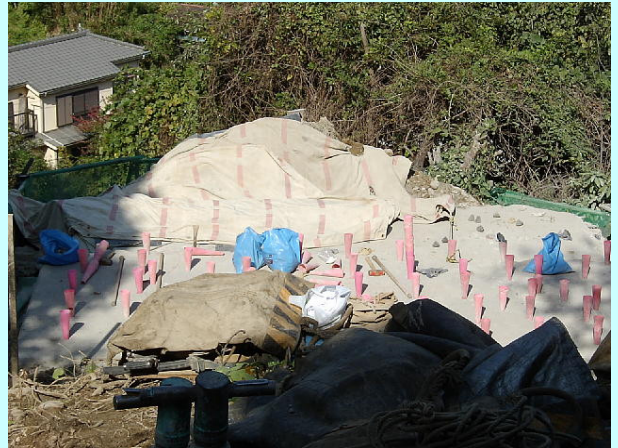
水平距離30mのところに民家あり、防護は確実に行う。
