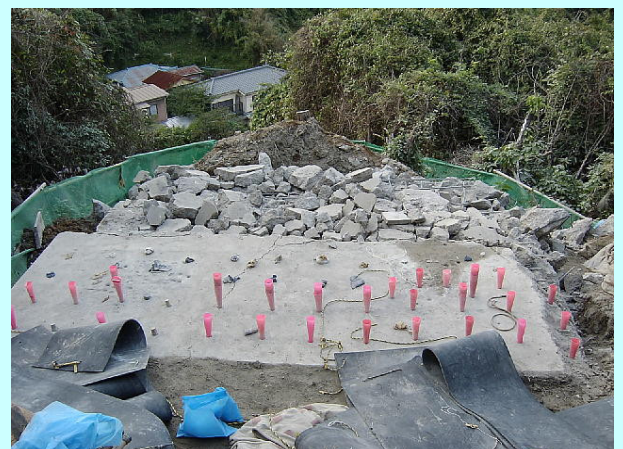
破碎コンクリート片は、飛び散らず破碎箇所に収まっている
