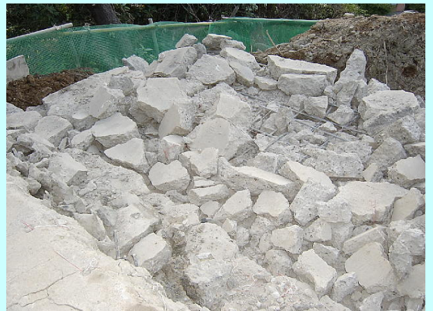
下段の破碎を7回に分割して行った後の破碎状況
